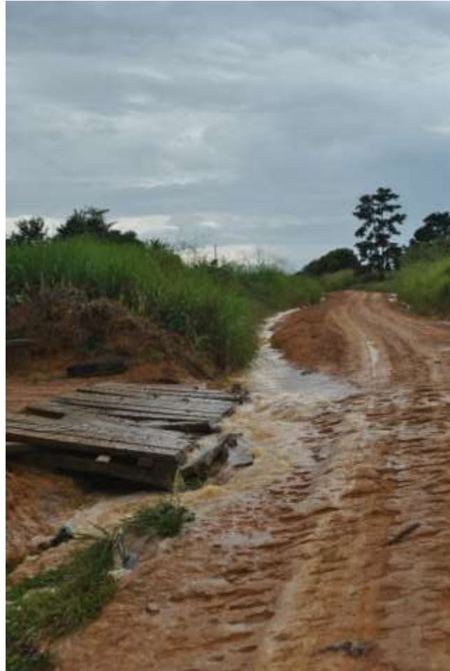
Foto: 0093 – Igarapé com água carreada da Estrada. Coordenadas: 09°37'40,1" / 63°57'33,8"
