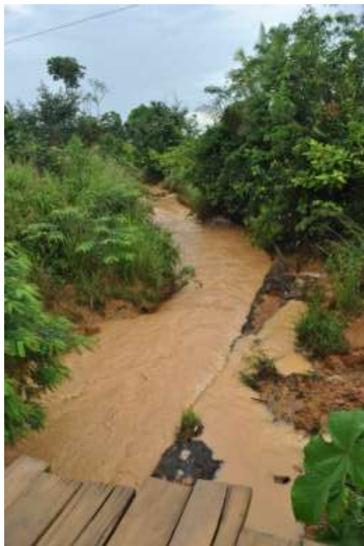
Foto: 0090 – Igarapé com água carreada da Estrada. Coordenadas: 09°37'40,1" / 63°57'33,8"
