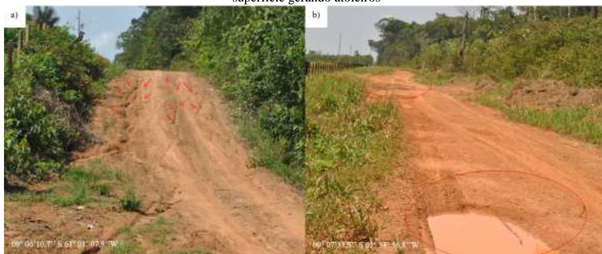
Figura 16 – Estradas com feições erosivas aparentes: a) Estrada do trecho 2 com aparente erosão em ravinamento e em entre-ravinas; b) estrada do trecho 1 que dá o acesso ao setor 1 da BHARG com concentração de fluxos de superfície gerando atoleiros
